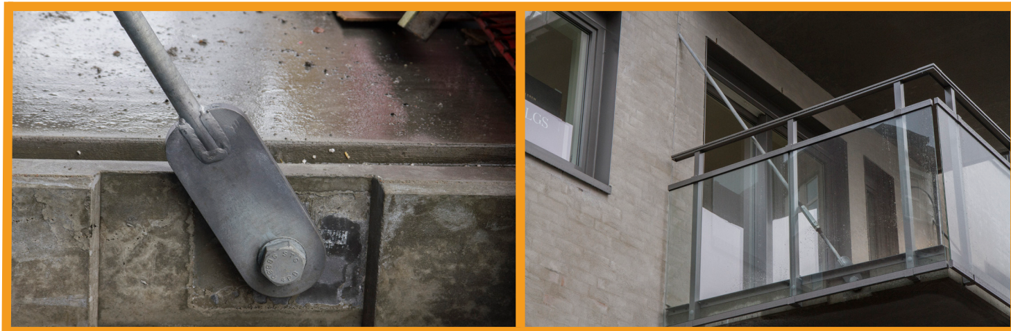
Viser innfesting mot innstøpt plate med gjengehylse i balkongdekke.
