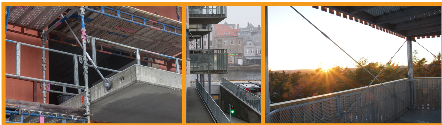
Viser innfesting mot sveiseplate mot fasade.
