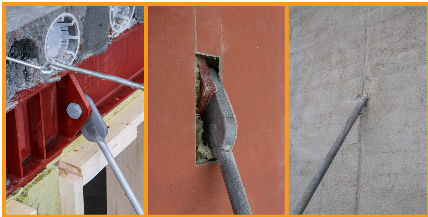
Viser innfesting mot sveiseplate mot fasade.
